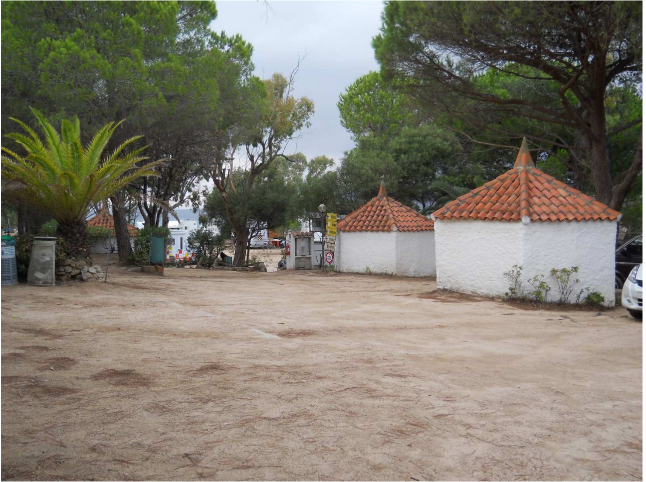
05/10/2015 Palau ..... bungalow nel camping Torre dei Saraceni
